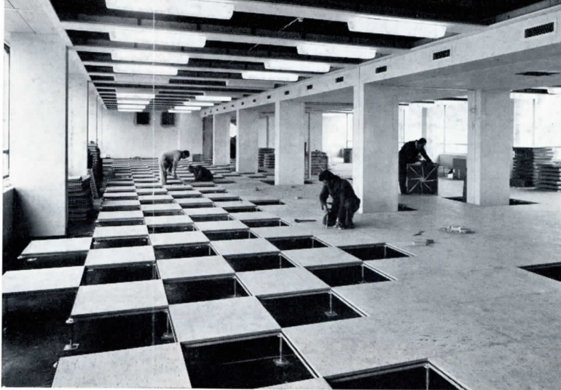
Het aanbrengen van de verhoogde vloer
